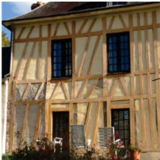
Colombage chêne naturel avec léger badigeon de chaux + remplissage enduit chaux/sable
